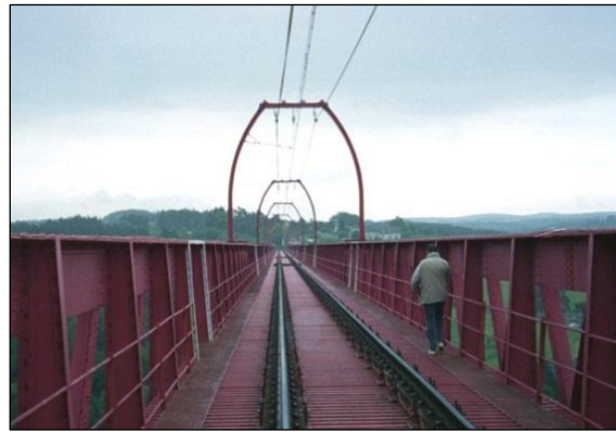
Illustration 14 : Position de la voie sur les viaducs de Maria Pia et de Garabit à gauche, le viaduc Maria Pia à droite, le viaduc de Garabit
