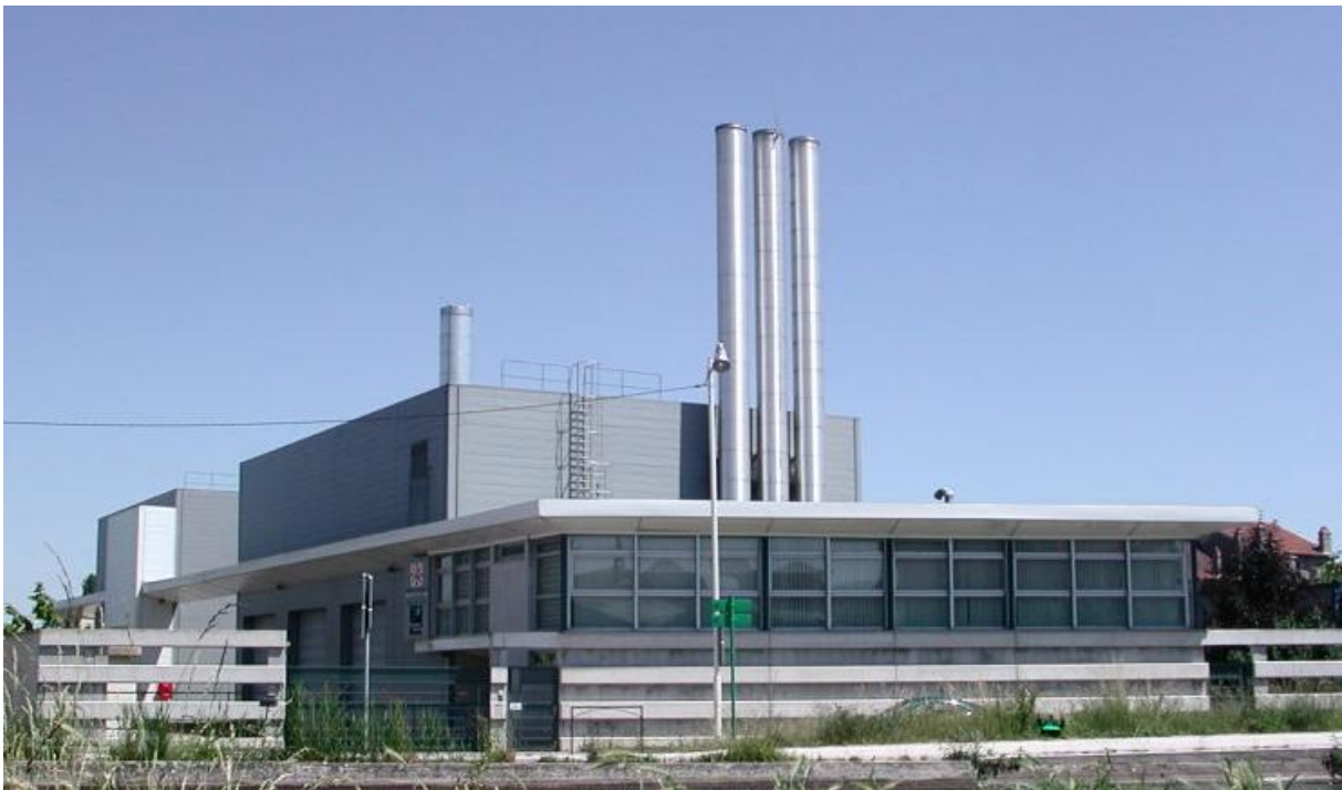
Figure 6 - Chaufferie Florentin (située entre le canal et la chaufferie Victor)
