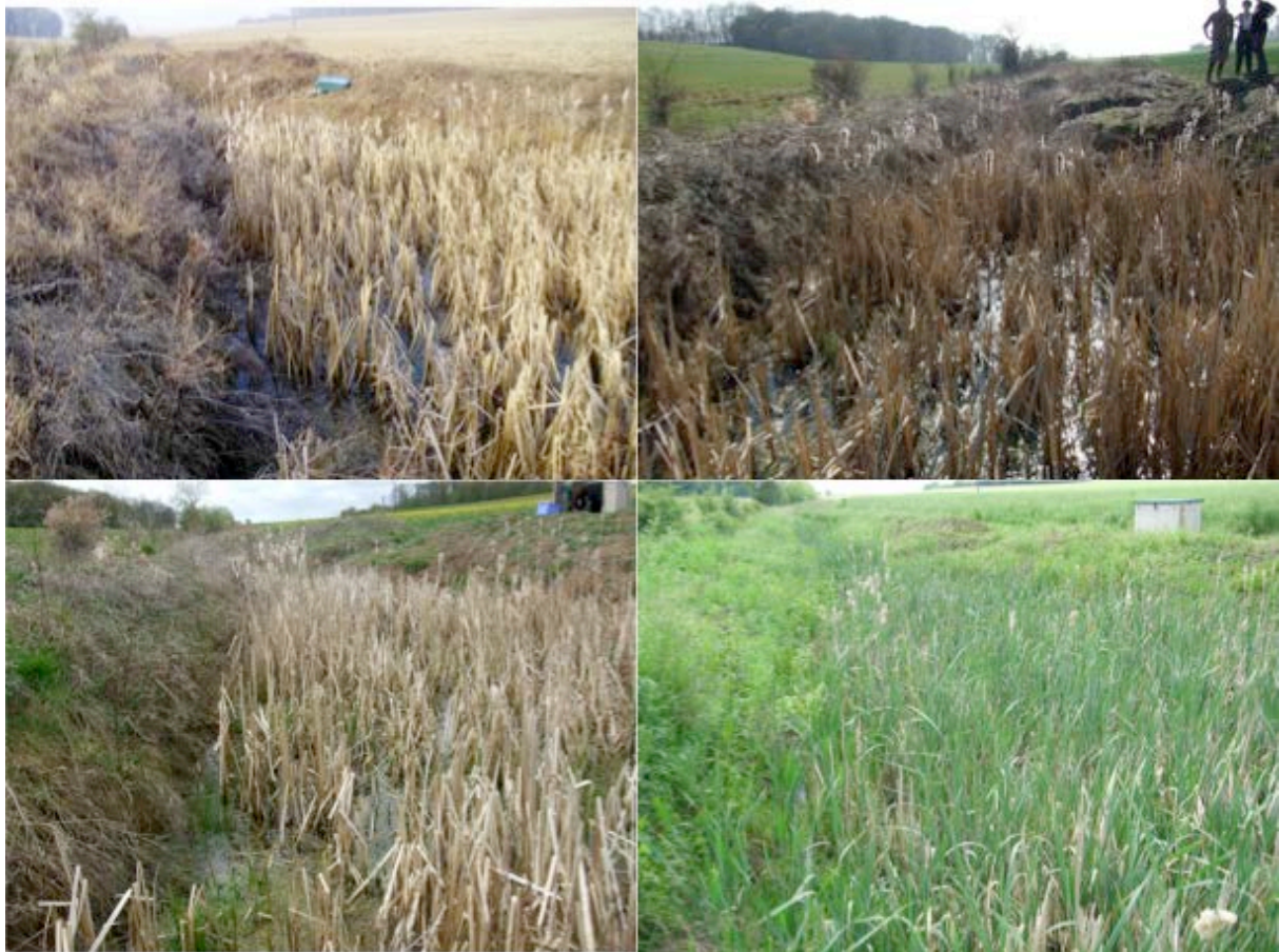
Site d'Ollainville. En haut à gauche : 27/02/2012, en haut à droite : 28/03/2012, en bas à gauche : 23/04/2012, en bas à droite : 05/04/2012
