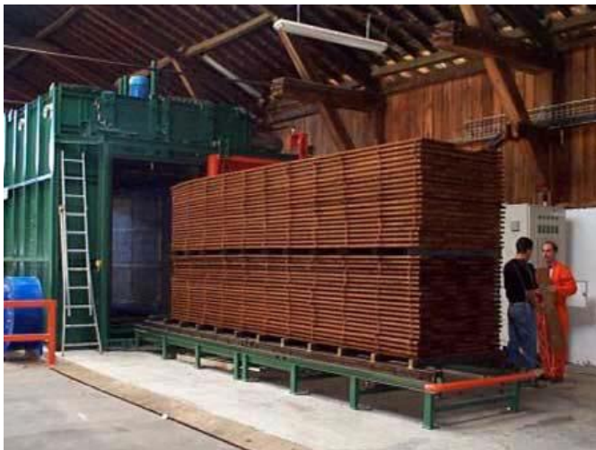
Figure 2 : Une charge de pièces de bois à l'entrée d'un four industriel (RETIFICATION®)
