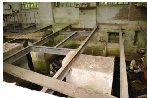
Intérieur de l'ancien poste gazométrique (sous-sol inondé)
