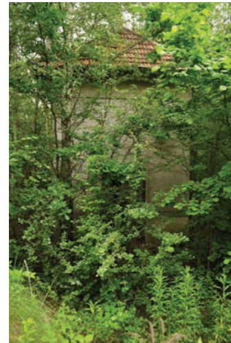
Façade de l'ancienne chaufferie
