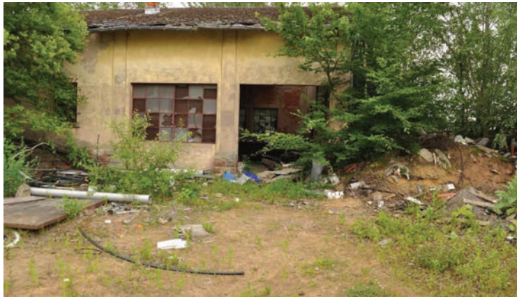
Ancien atelier magasin localisé sur la parcelle de l'ancien gazomètre
