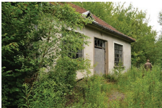
Ancien poste gazométrique
