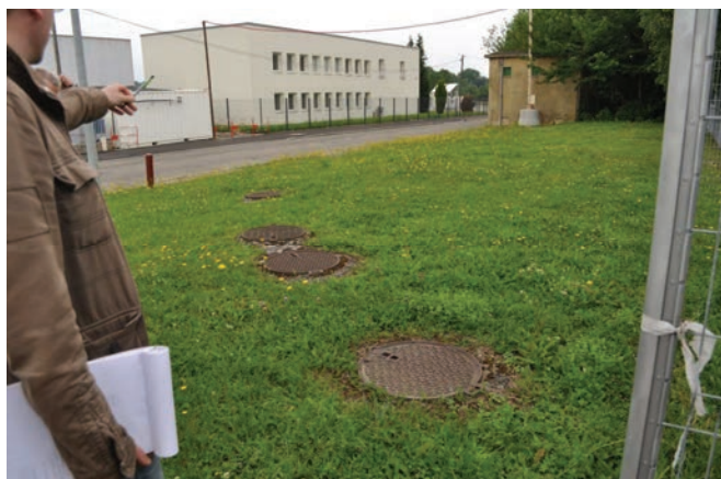
Système de séparation des hydrocarbures (devant l'entrée du site)
