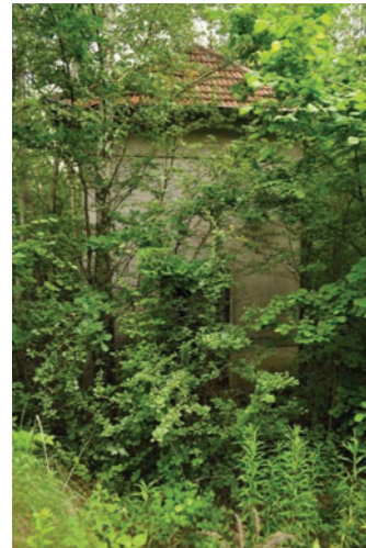
Façade de l'ancienne chaufferie
