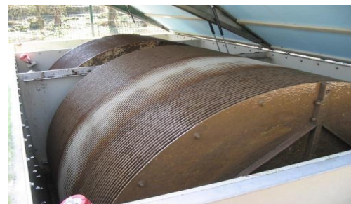
Figure 11 : Schéma de principe de la filière à disques biologiques et exemple d'une installation. ( http://www.oieau.org et Cg29-DEE-SATEA, 2008)
