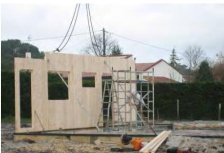
*Figure 5 : Pose d'un mur de panneau contrecollé sur chantier*
