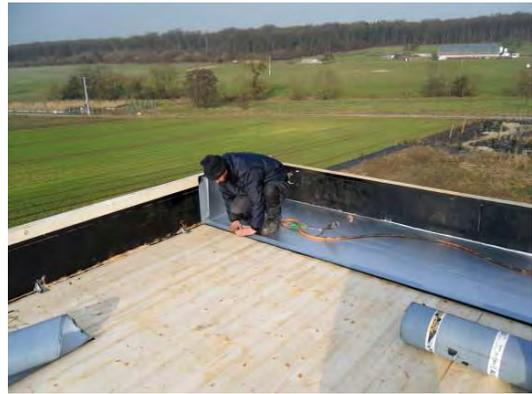
*Figure 6 : Pose de l'étanchéité au niveau de la toiture*
