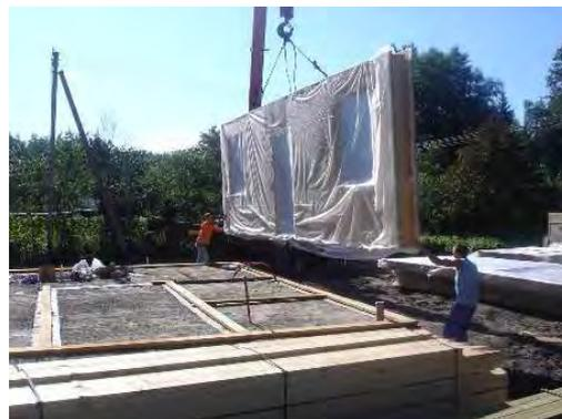
Figure 3 : Pose d'un mur ossature bois sur chantier
