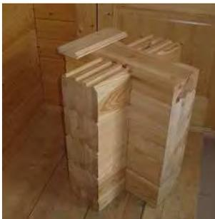
Un élément fondamental à prendre en compte dans ce mode de construction est le tassement, il faut considérer un tassement pouvant atteindre 25mm par étage. Cette déformation doit être prise en compte par des mesures constructives.
