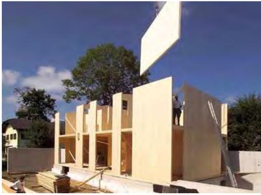
*Figure 7 : Assemblage des différents murs*
