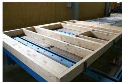
Figure 1 : assemblage de la trame en bois
