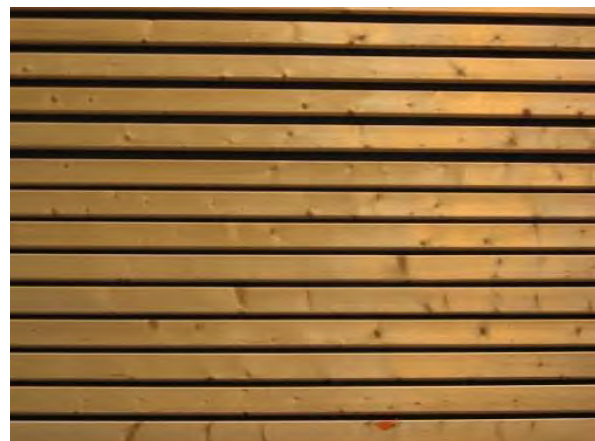
Figure 47 Un mur de résonateurs constitué de lames de bois
