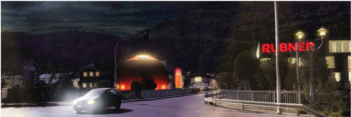
Un bâtiment phare qui donne à voir aussi bien qu'il est vu de nuit
