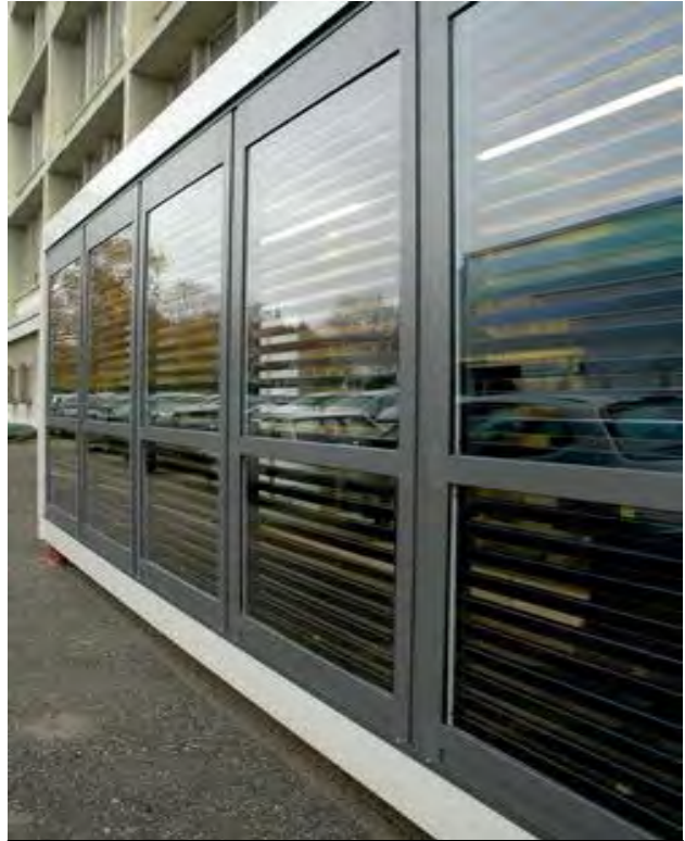
Figure 15 : vitrage Climatherm façade Sud-Est
