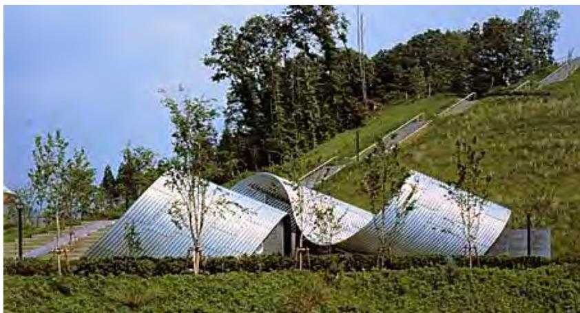
De ce concept en découle une architecture qui n'est pas composée en poteaux/murs/planchers mais par une enveloppe continue.
