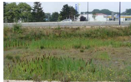
Photo 19 : Bassin de rétention
