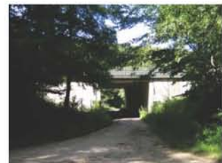
Photo 9 : Chemin agricole sous l'A36
