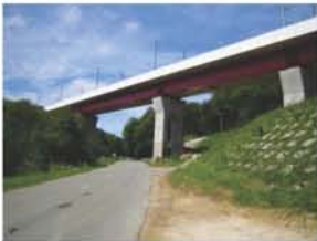
Photo 10 : Viaduc du Pertuis
