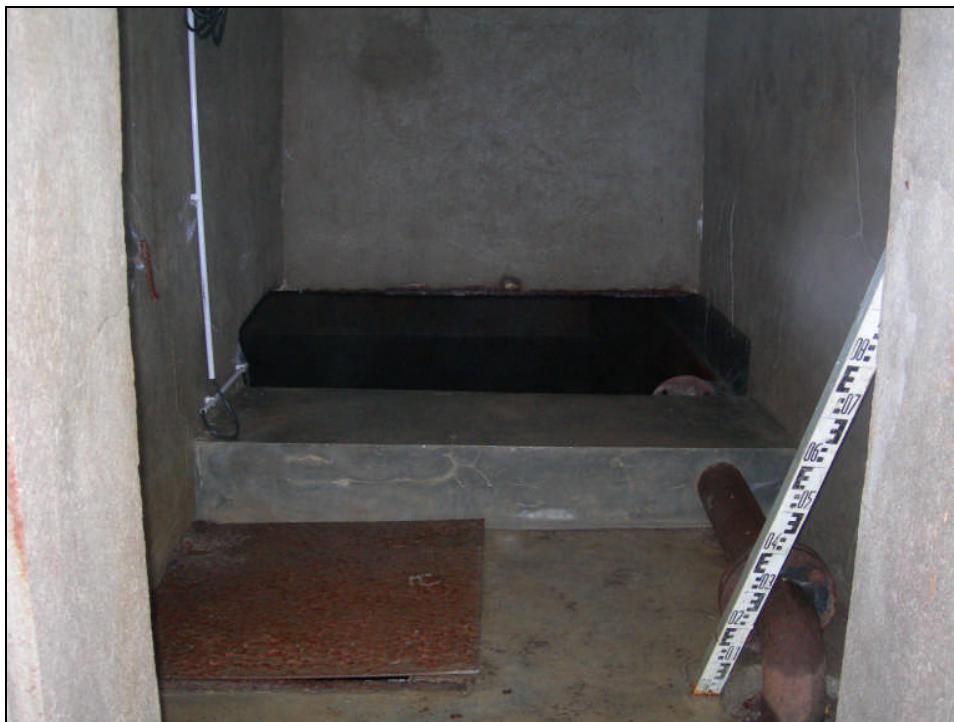
Photo a : Intérieur du local du réservoir
