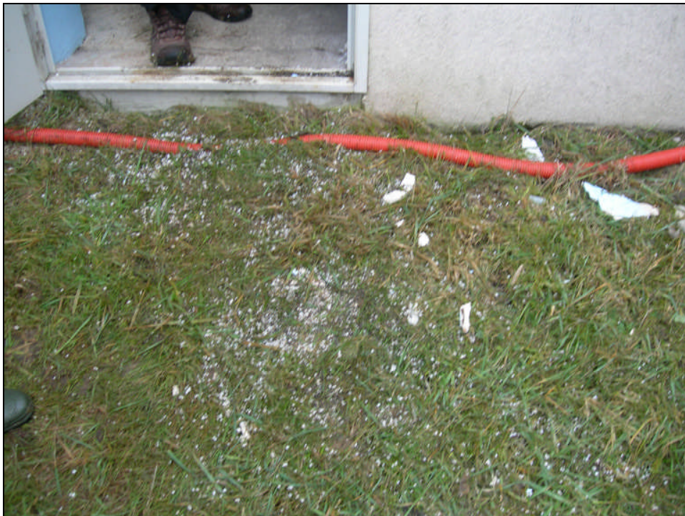
Photo b : Etat d'entretien du local béton
