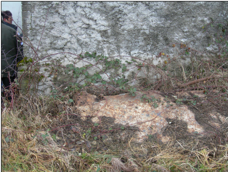
Photo d : Etat extérieur du local contenant le réservoir d'eau
