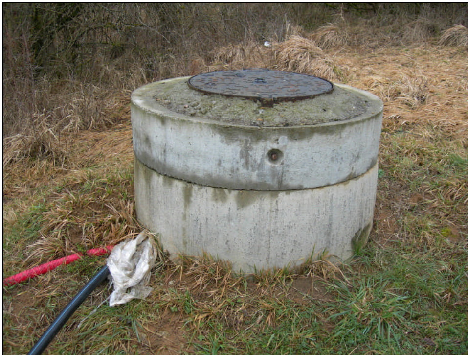
Photo a : Tête du forage F
