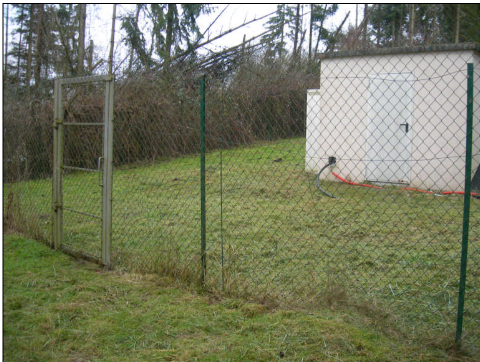
Photo d : Périmètre de protection immédiat
