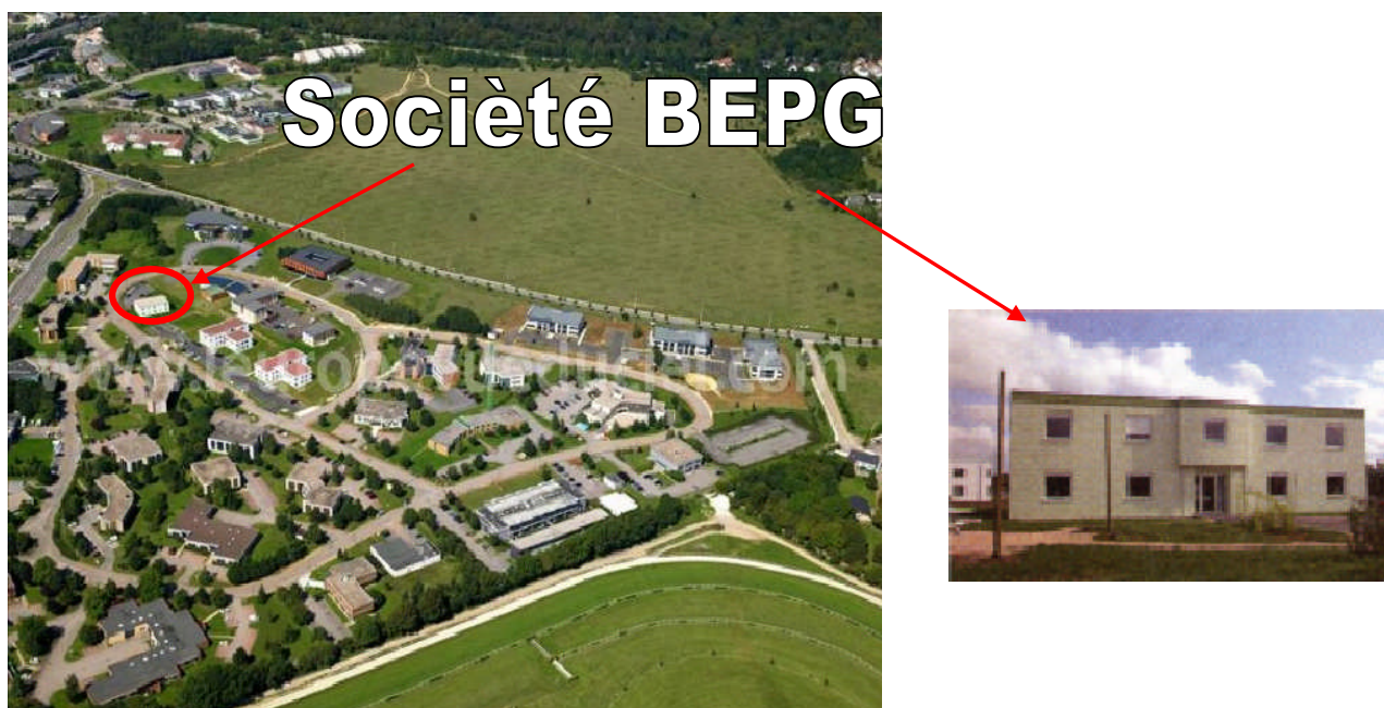
Figure 1 : Situation géographique de l'entreprise
