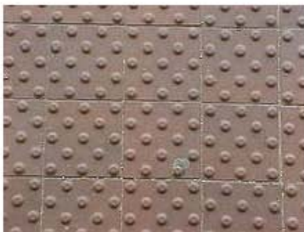
Figure 16 : Gros plan sur un exemple de surface podotactile
