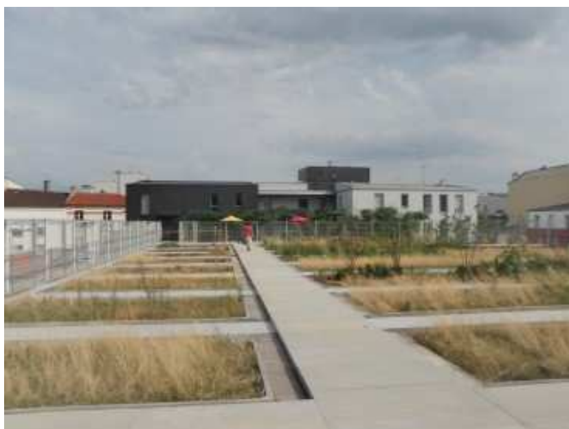
Annexe 8 : Toit du gymnase des Vignobles, Paris 20 ème arr.
