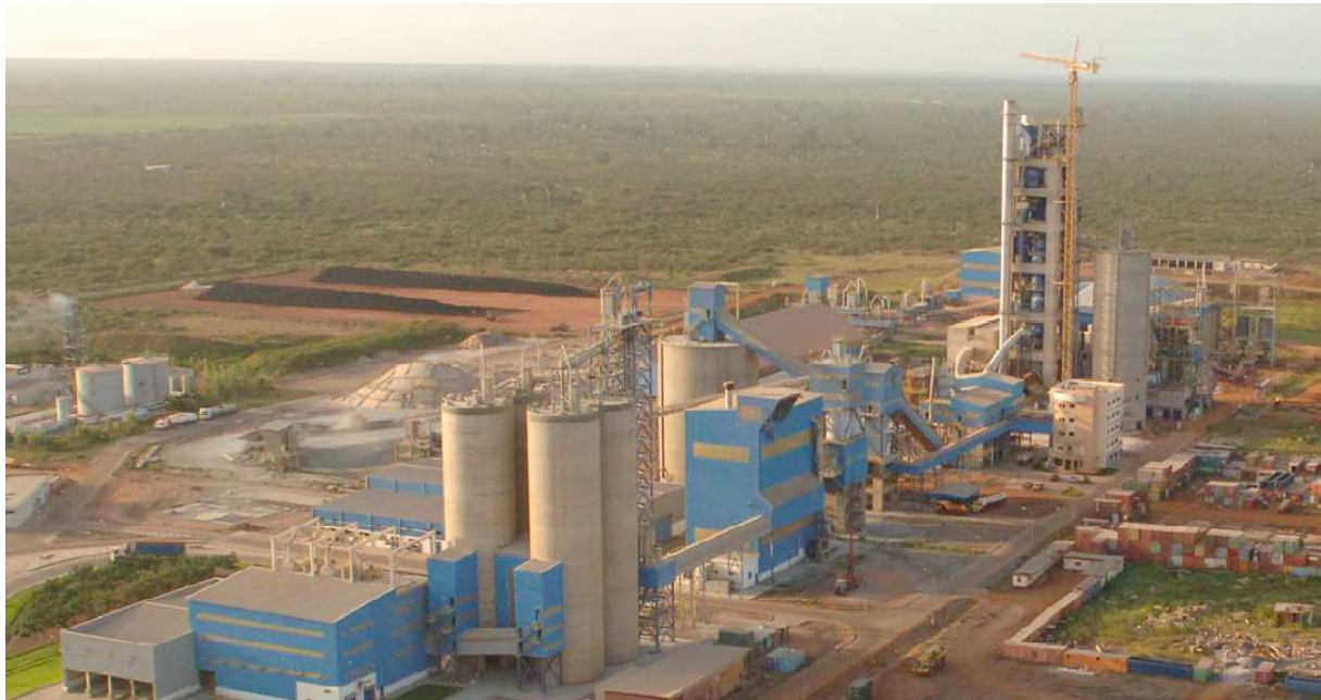
Figure 30 : vue de la cimenterie au début des années 2000, CESA Engineering Février 2010
