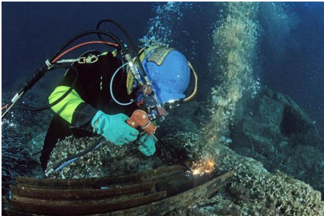
Figure I-7 Plongeur effectuant des travaux de soudure en milieu hyperbare [14]
