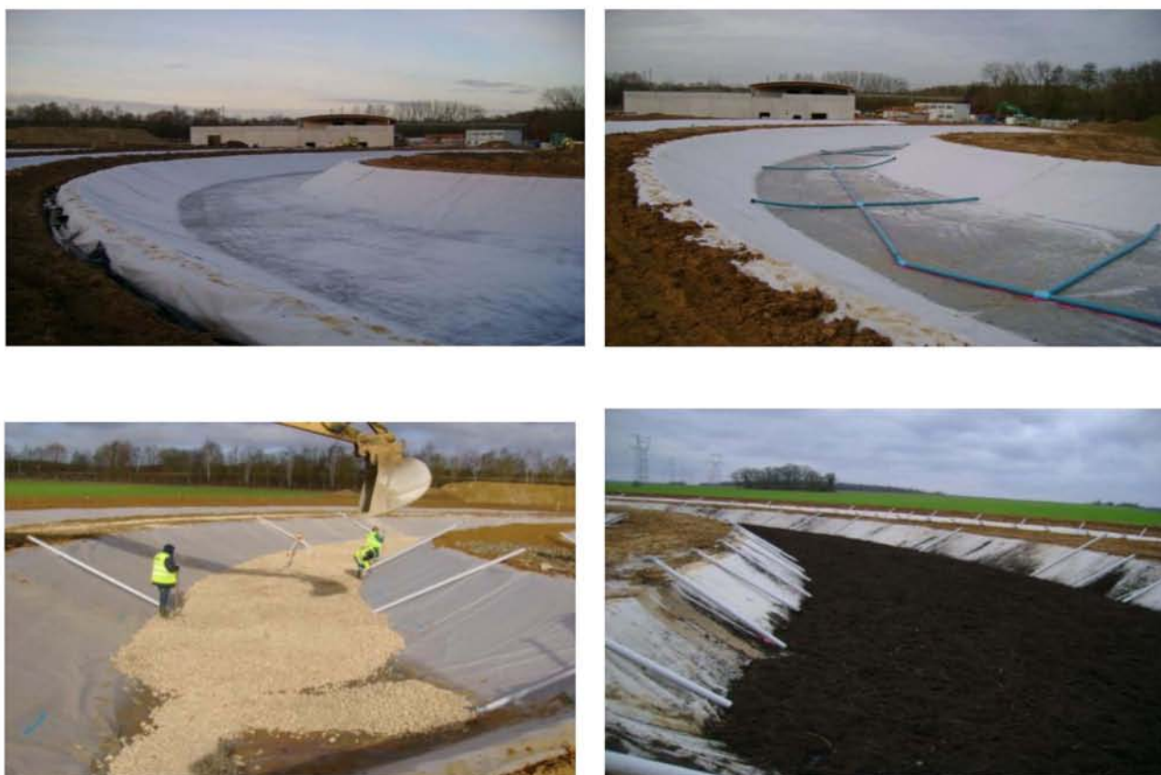
Figure 4: Exemple de construction des Jardins Filtrants® boue de Briis sous Forges (91) en 2008 (source : Phytorestore)
