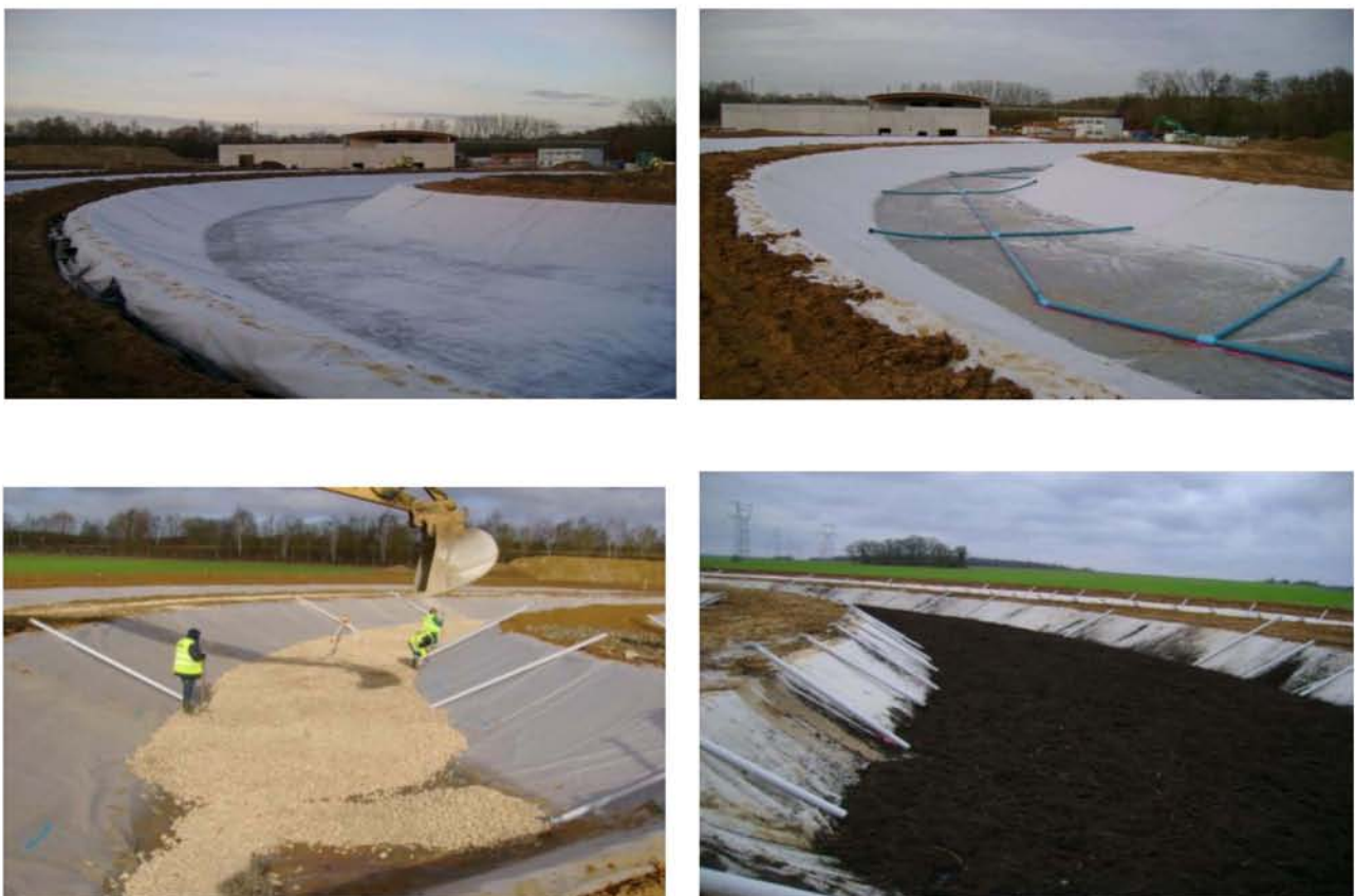
Figure 4: Exemple de construction des Jardins Filtrants® boue de Briis sous Forges (91) en 2008 (source : Phytorestore)
