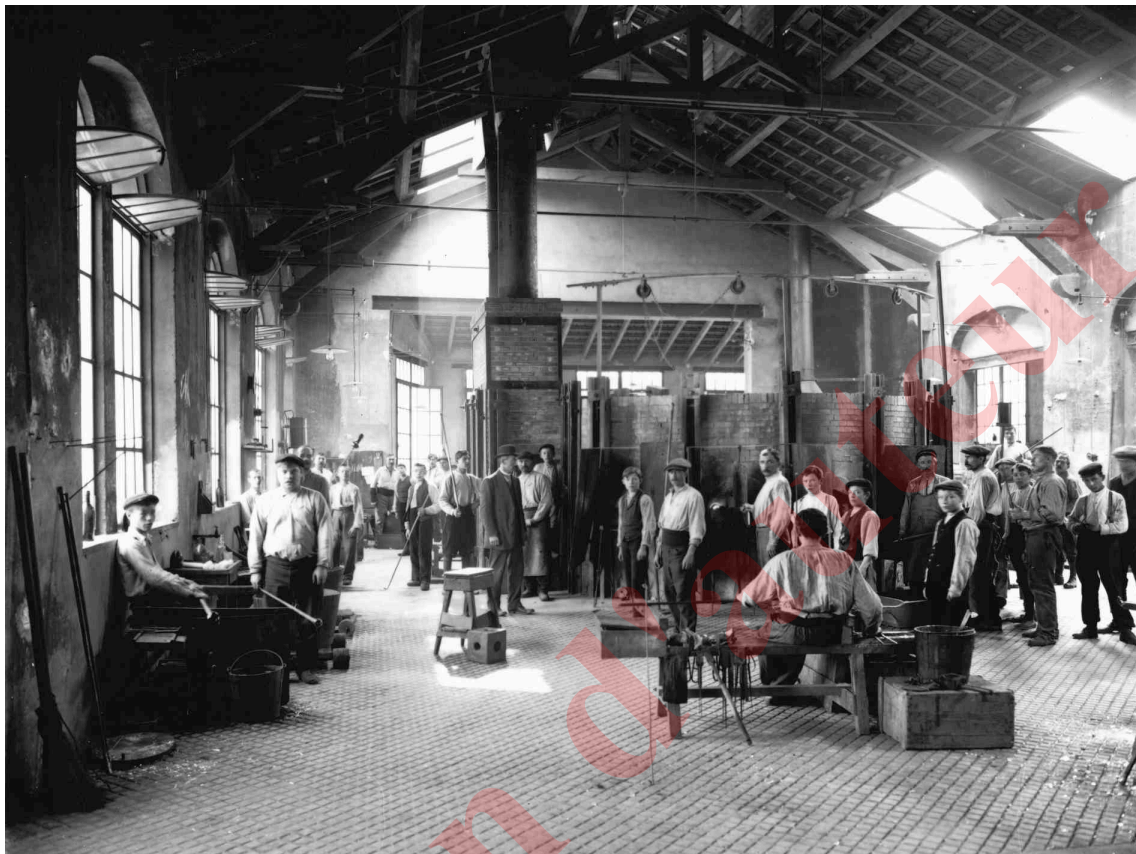
Fig. 3. Anonyme, La halle de verrerie Gallé (vers 1912), tirage d'après la plaque photographique argentique originale, coll. part. Photographie du four mis en service à la fin de 1911 et dont l'arrêt accidentel en juin 1914 handicape la production pendant toute la guerre.
