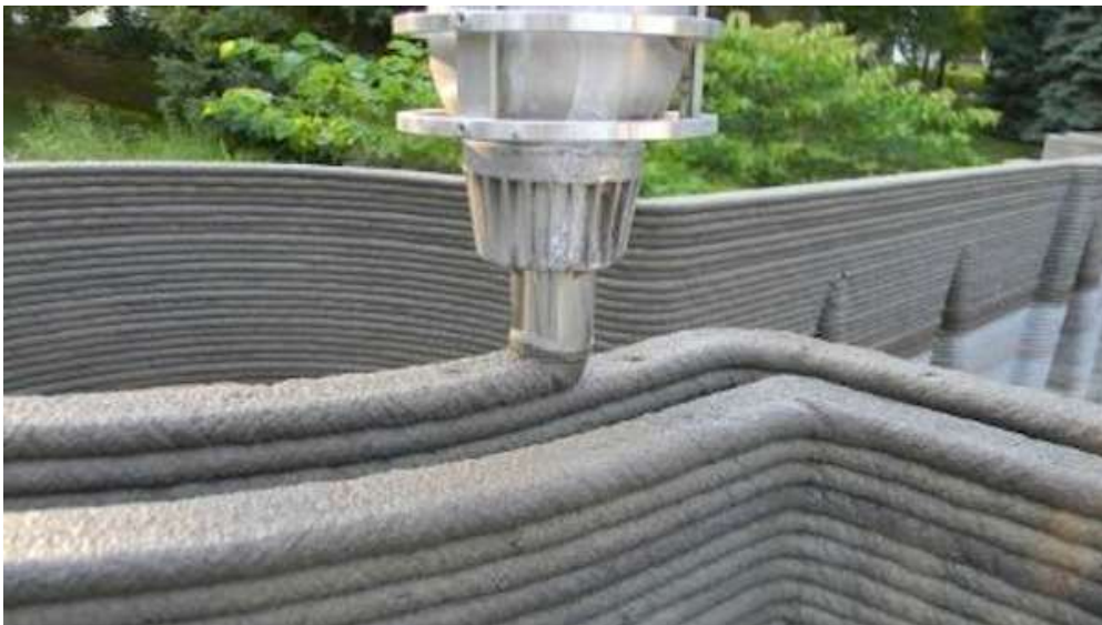
Figure 156 : Impression 3D de maison en béton (Source : bekkeringadams)
