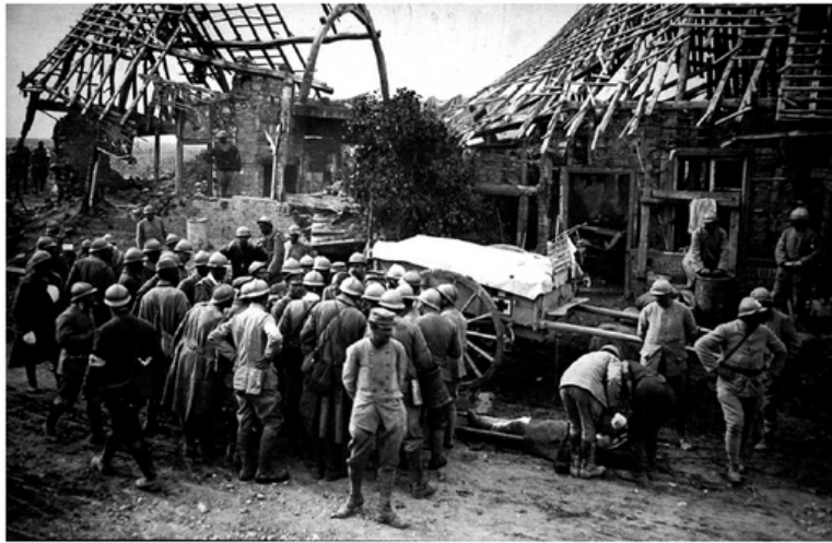
Figure 49 : Herbécourt (80200). Poste de secours avancé installé dans les ruines [54]
