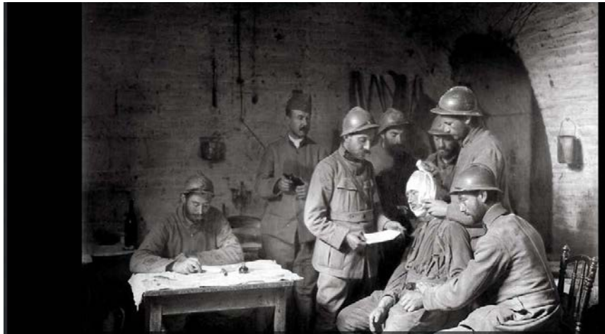
Figure 48 : Un blessé se fait soigner dans la salle de pansement installée dans l'ancien poste de secours allemand dans les souterrains de l'ancien château de Combles lors de la bataille de la Somme (tiré de lillustration.com) [54]
