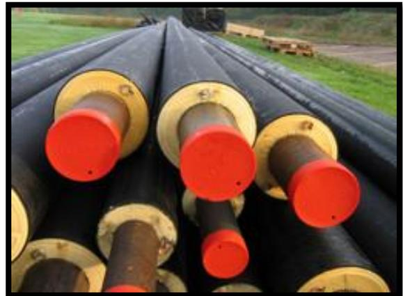
*Figure 7 : Canalisations pré-isolées en attente de pose*
