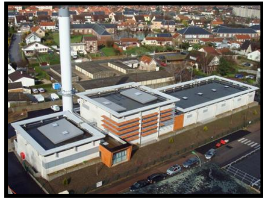
Figure 5: Centrale biomasse avec réseau de chaleur Saint-Etienne du Rouvray (76)
