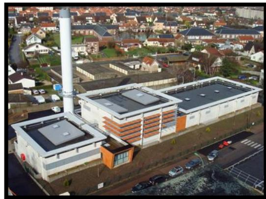
*Figure 5: Centrale biomasse avec réseau de chaleur
