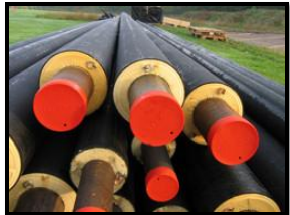
Figure 7 : Canalisations pré-isolées en attente de pose
