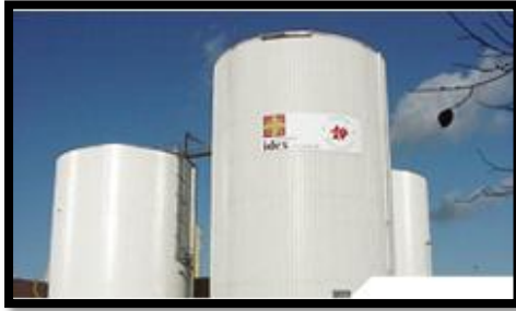
Figure 4 : Usine de méthanisation à Amiens ( 10 millions de Nm 3 /an de biogaz produit)
