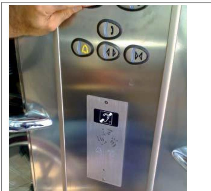
Figure 12 : Boucle d'induction magnétique dans un ascenseur. [25]
