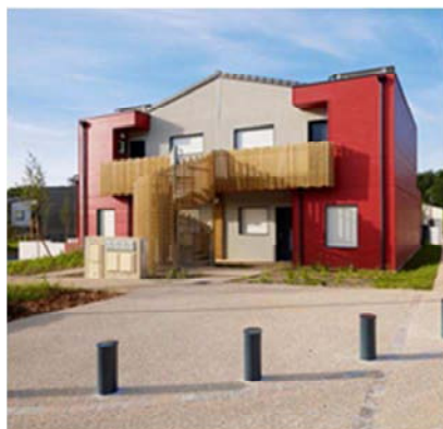
Figure 32 : Habitats groupés posés par BH
