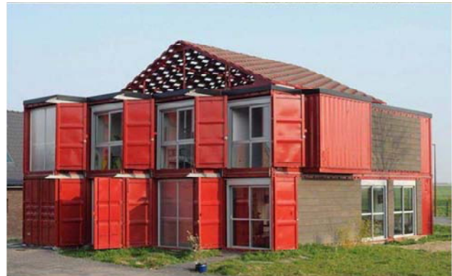
Figure 22 et 23 : Maisons Containers
