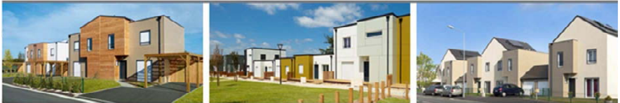
Figure 31 : Maisons posées par BH
