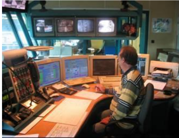
Figure 5 : Photo de la Salle de contrôle
