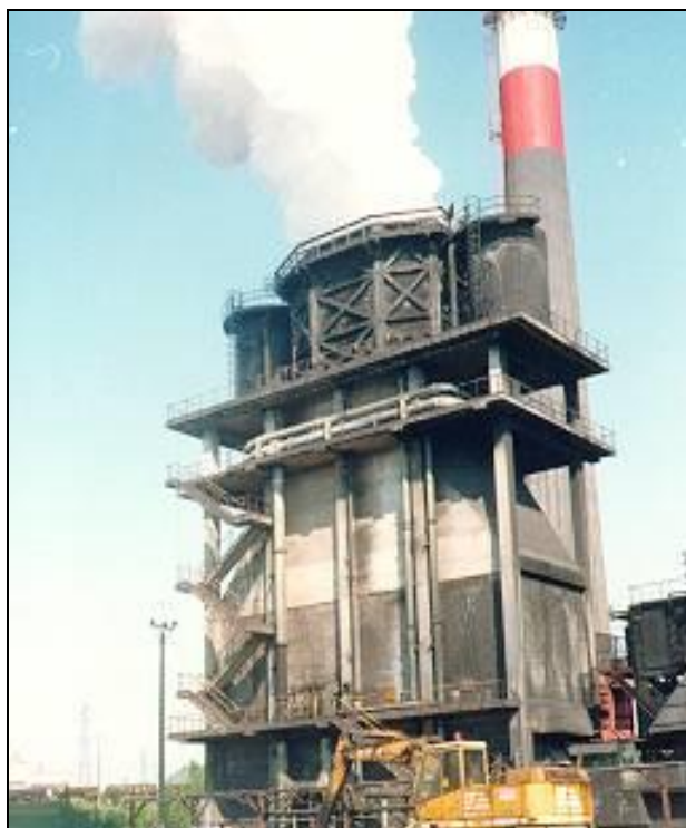
Figure3: Photo tour d'extinction du coke
