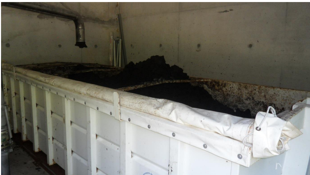
Photo 17: Benne à boues déshydratées.
