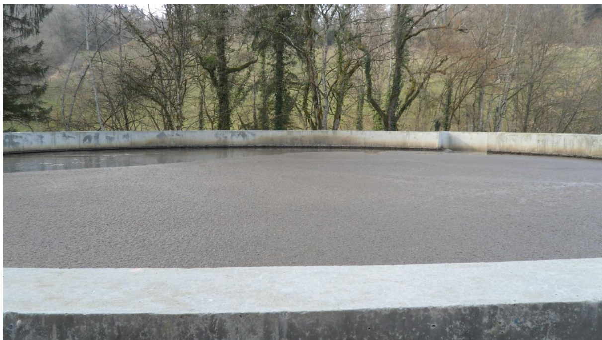
Photo 7: Bassin d'aération récent (rond).
