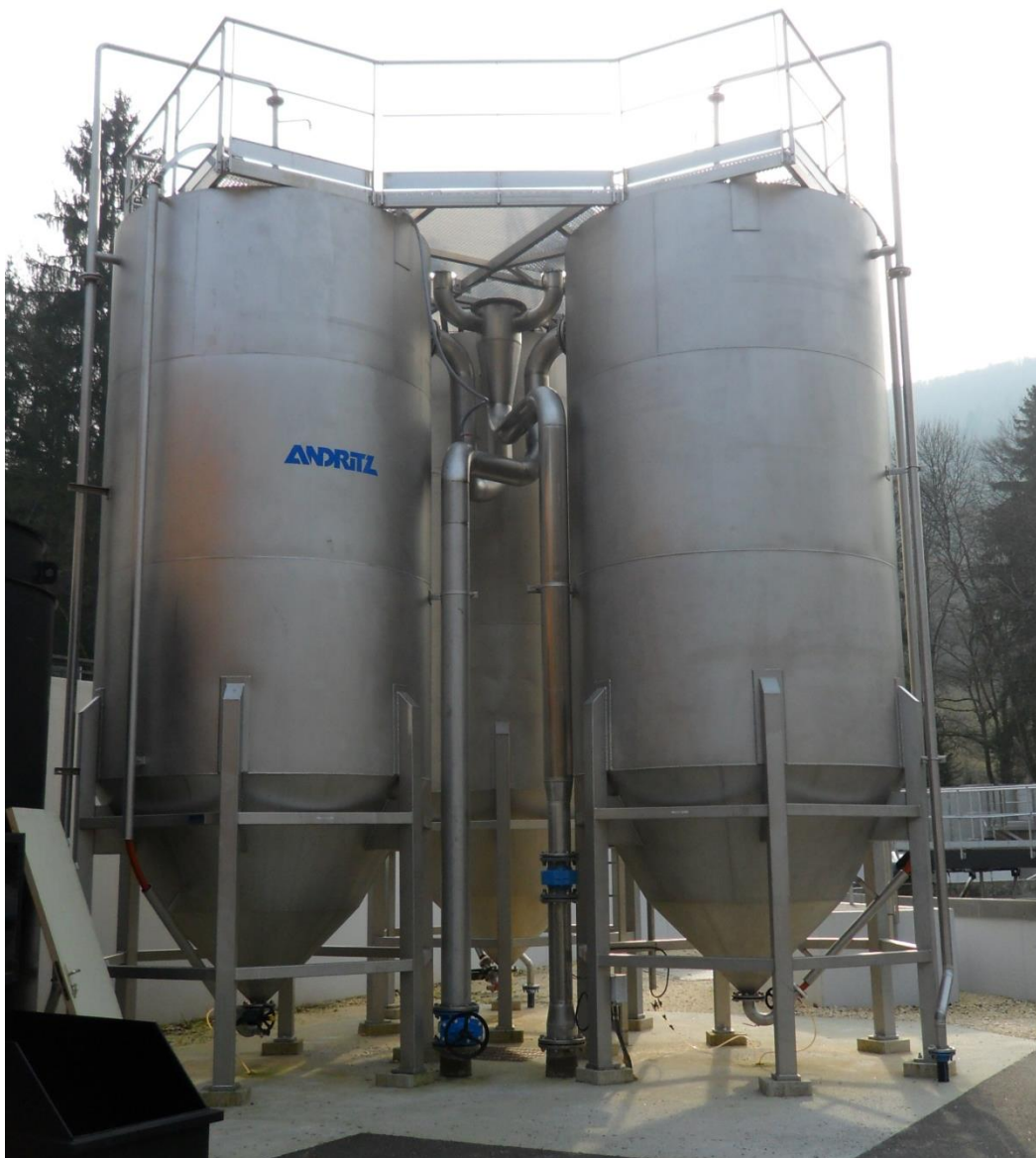
Photo 11: Hydrasand (filtres à sable).
