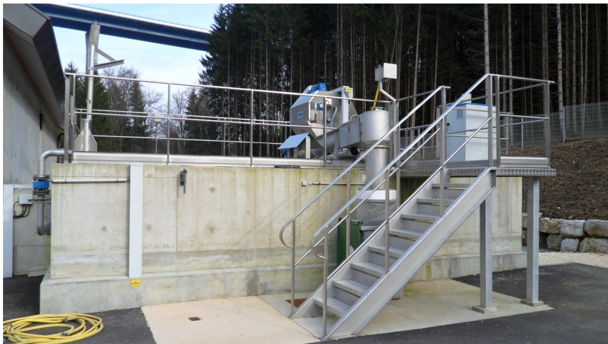
Photo 1: Ouvrage d'acquisition des eaux brutes.
