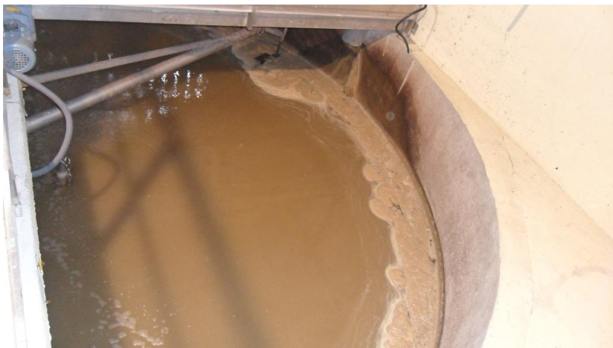
Photo 4: Dégriaisseur/dessableur.
