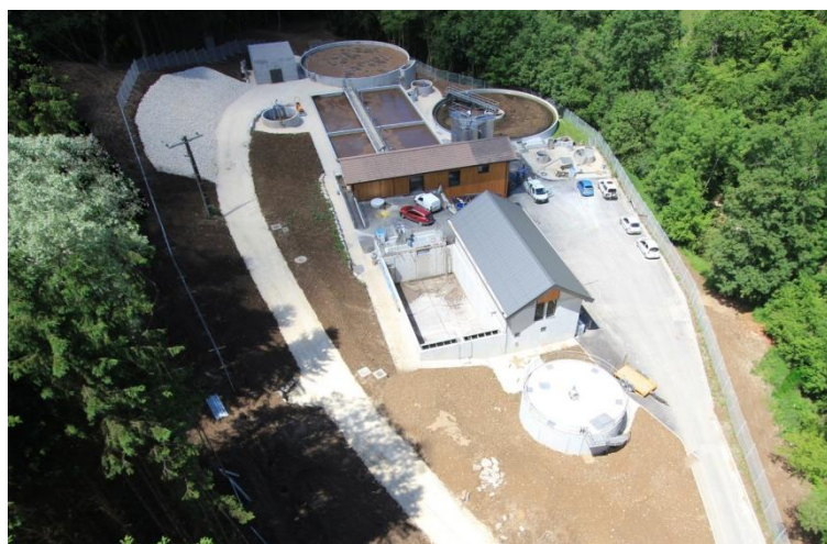
Figure 3: Vue aérienne de l'UDEP le Nautil'Usses.
