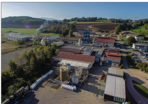
Figure 1 : Site de production de Baikowski France (Poisy)
