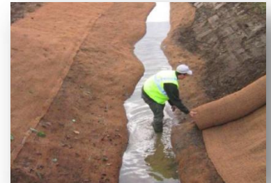
Photographie 4: Exemple de réalisation de banquettes, source SIERM
