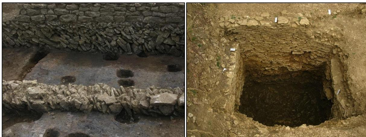
**Figure 83 : exemples de mise en œuvre de la plaquette calcaire à Senon dans la fondation d'un mur et comme matériau de parement d'une glacière (cliché INRAP GEN)**
