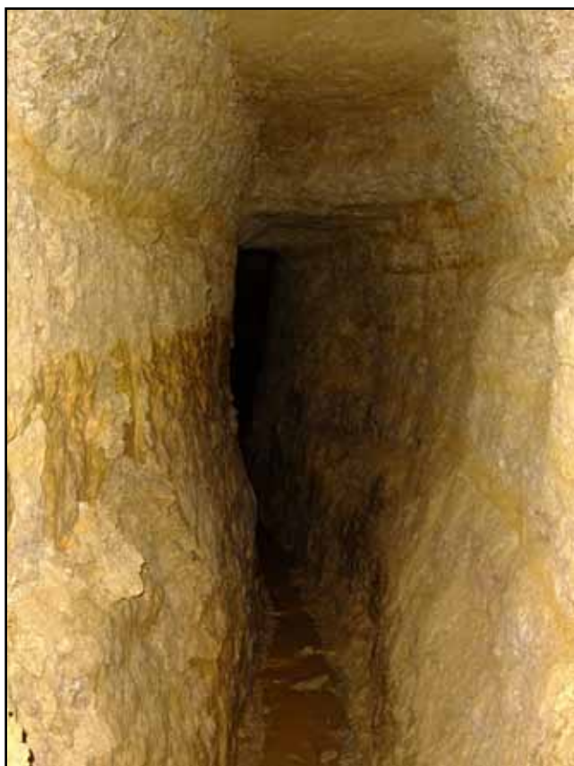
Figure 211 : l'aqueduc souterrain de Vaudoncourt (cliché : B. Losson)
