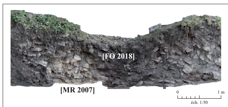
Figure 131 : vue de tranchée de fouille [FO 2018] dans la coupe est (orthophotographie/DAO : S. Ritz)
