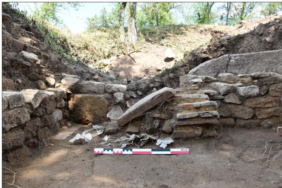
Figure 82 : vue vers l'est de l'hypocauste en cours de dégagement. Notez les sacs plastiques qui recouvrent le dallage [US 1044] (cliché : S. Ritz)
