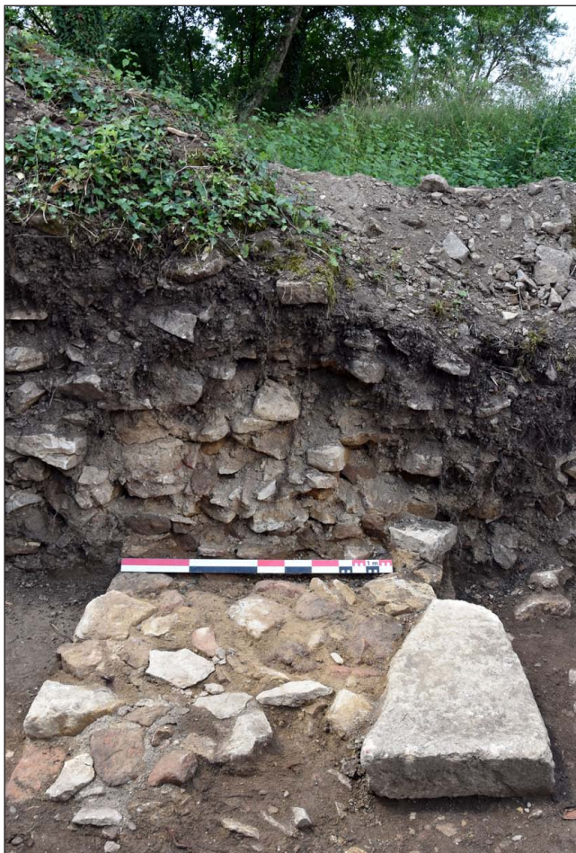
Figure 122 : vue vers l'ouest du rempart [MR 2007] (cliché : S. Ritz)
