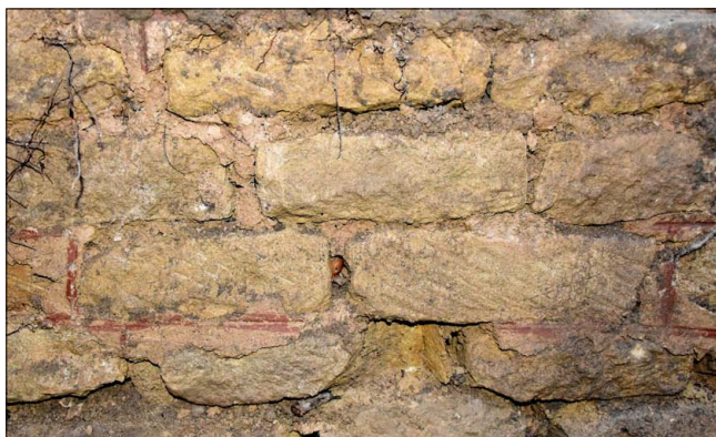
Figure 257 : vue de détail des joints regarnis in situ (cliché : S. Ritz)
