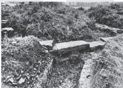
Les fondations de la curie (cliché F. Drexel, 1918)
