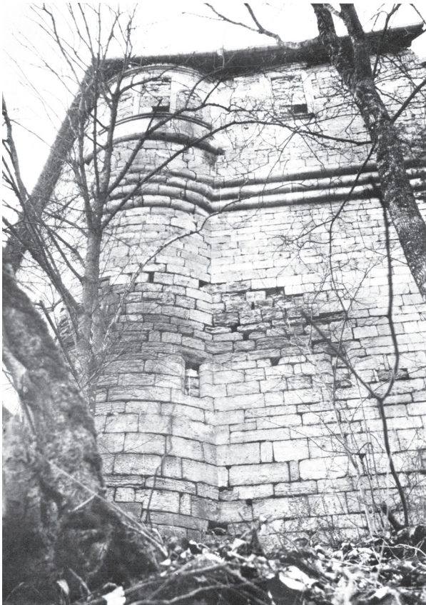
Fig 5b : Château de Pierrefort, angle nord-est (1980)
