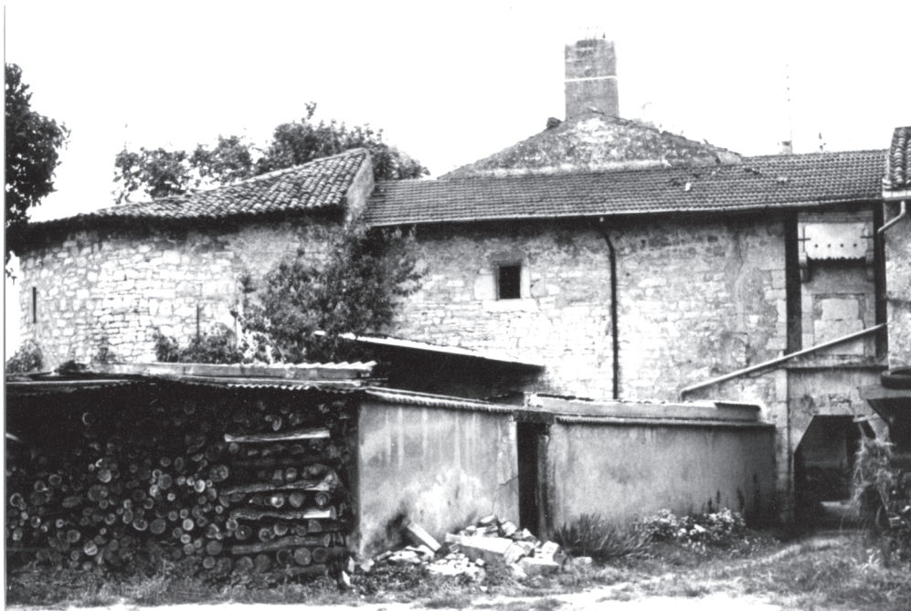
Fig. 25 : Ogéville, Meurthe-et-Moselle, tour nord (1996) ; Damelevières, Meurthe-et-Moselle, maison forte XV e siècle (1989)
