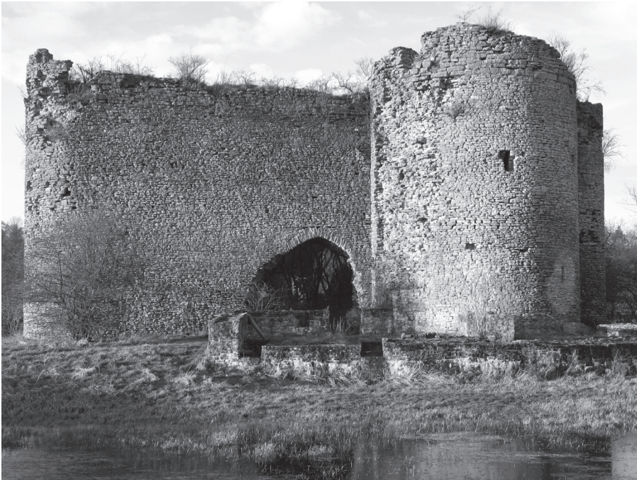
Fig.6b : Niederstinzeln, maison forte vue du côté sud
