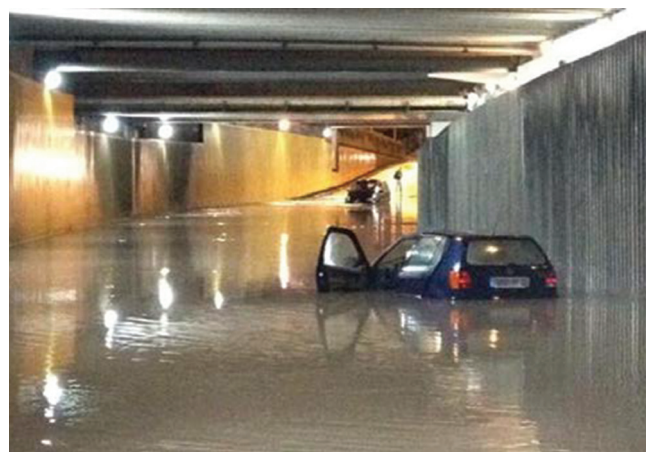
Figure 5 : Passage souterrain inondée à Bordeaux. (source: journal « Sud Ouest », 2013).
