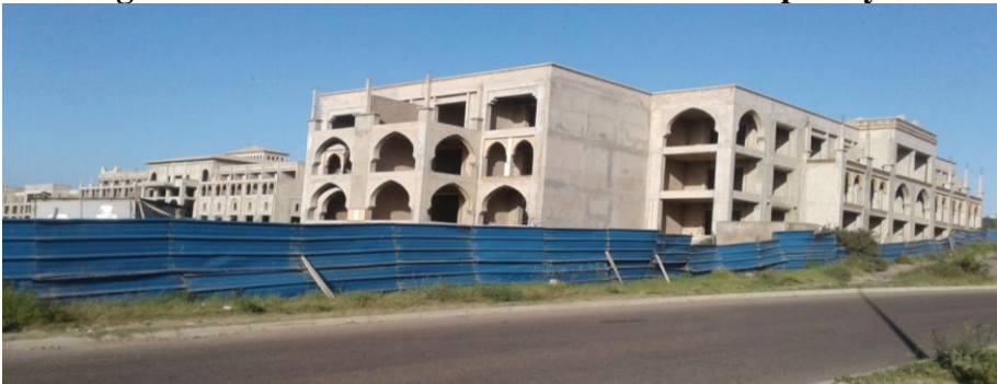
Figure 7 : Le chantier décennal de l'hôtel Kempinsky
