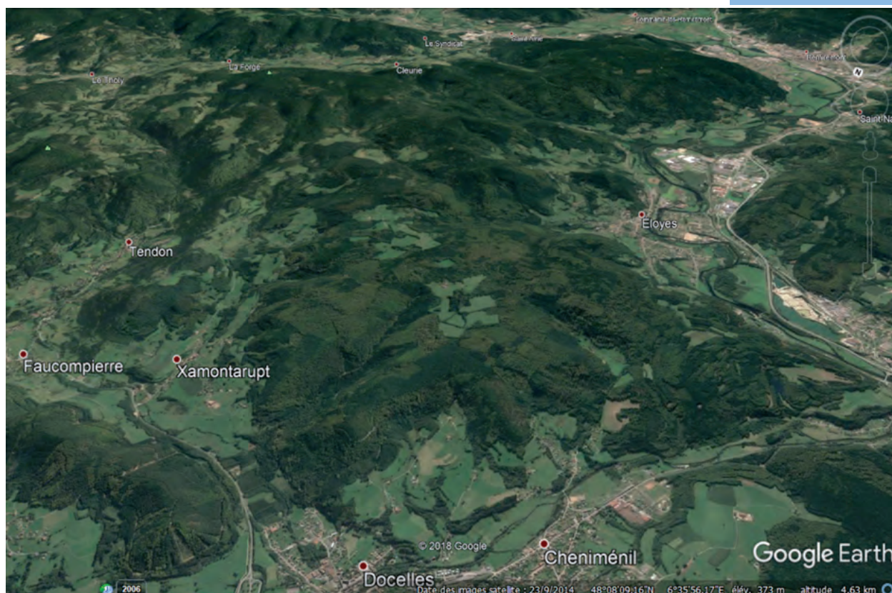
Figure 4 - Image du plateau du Fossard (Google Earth ; orientation vers le sud-est)
