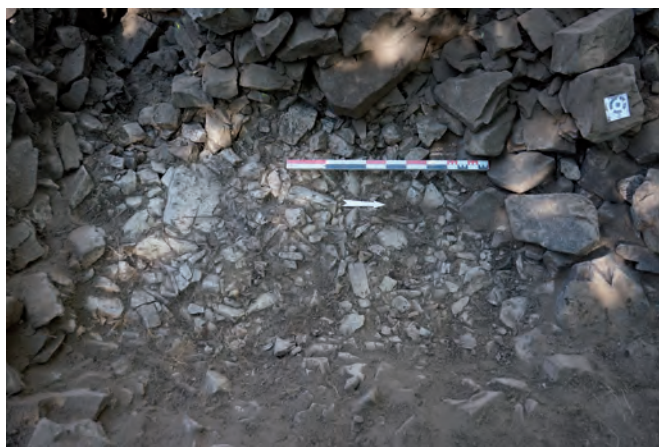
Figure 67 - Blocs disposés en boutisses parpaignes
