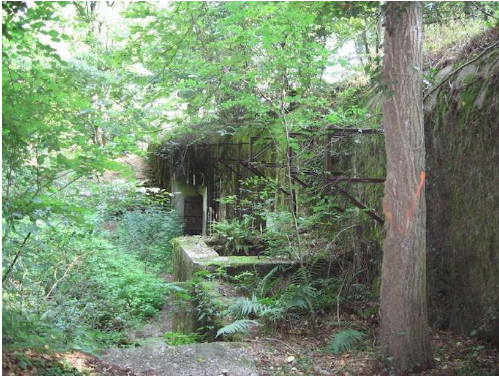
Figure 7. De grands ouvrages de béton camouflés sous la forêt
