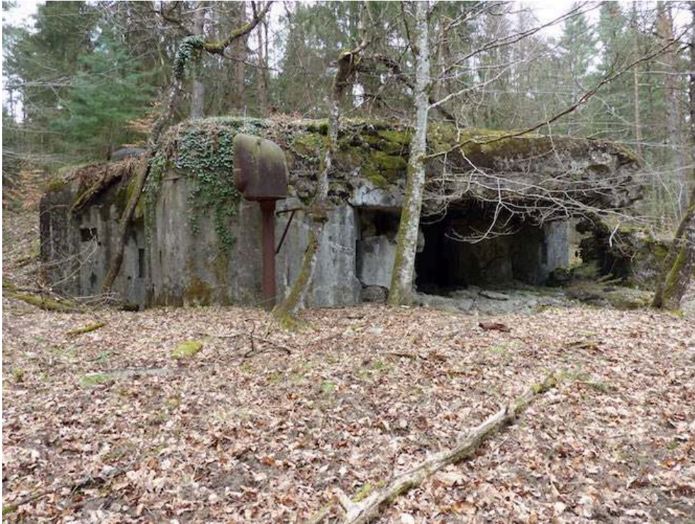
Vosges du Nord. Casemates CORF éventrées et à l'état de ruines. Source : Anne Mathis, 2019.
