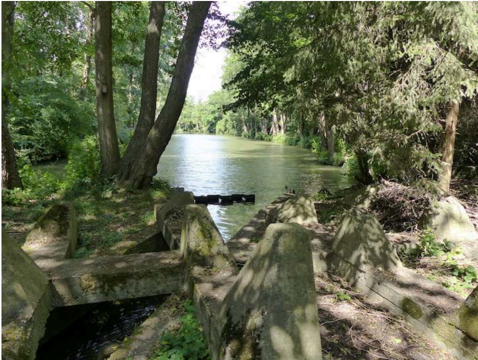
Figure 10. Les vestiges linéaires du Westwall
