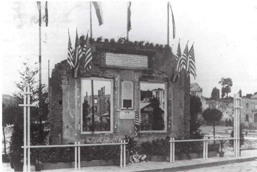
DOC.5 : La façade de la Maison de l'Amérique lors de la visite d'une délégation de l'American Legion, 21 septembre 1947 (Fonds Société philomatique). La troisième plaque est située entre les deux fenêtres, sous celle de 1921.
